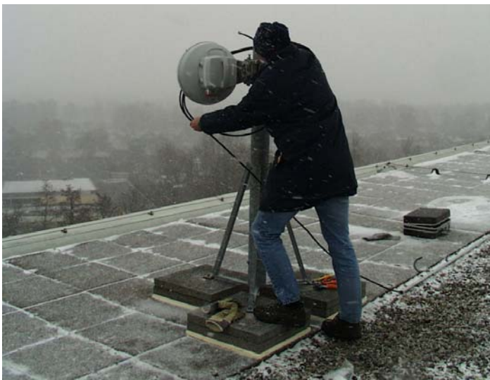
Bei Wind und Wetter: ETe-Techniker bei der Inbetriebnahme der Richtfunkstrecke. Aufbauhöhe dieser Einheit: 34m über Grund.
