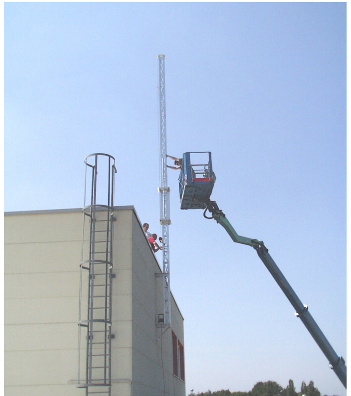
Montage des Antennenmastes auf dem Gebäude der Firma AGOFORM.
